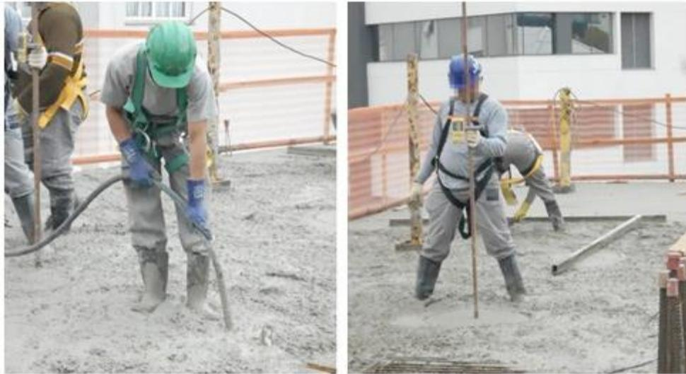
Figura 3 - Adensamento de concreto com vibrador e nível a laser (Fonte do autor)
