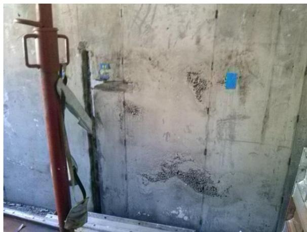
Figura 16 - Bolsões de segregação do concreto (Fonte do autor)
