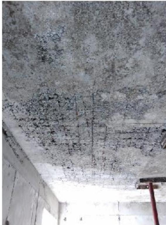
**Figura 17 - Armaduras da laje exposta (Fonte do autor)**
