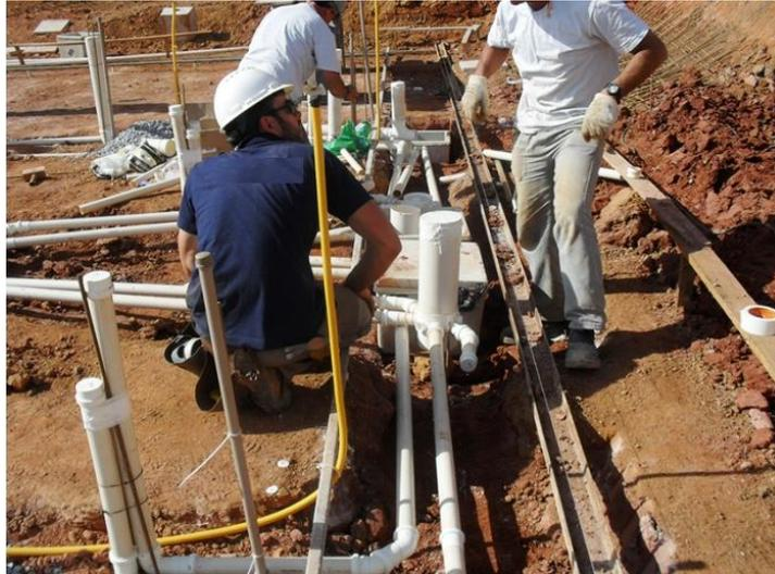
Figura 2 - Instalações na fundação (Fonte do autor)
