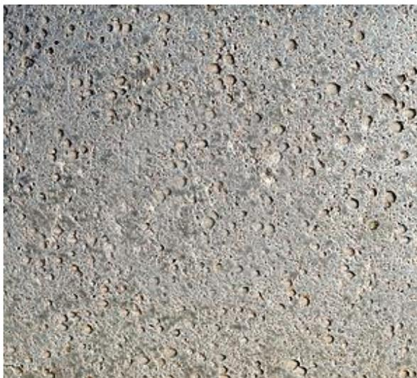
**Figura 22 - Porosidade excessiva na parede (Fonte do autor)**
