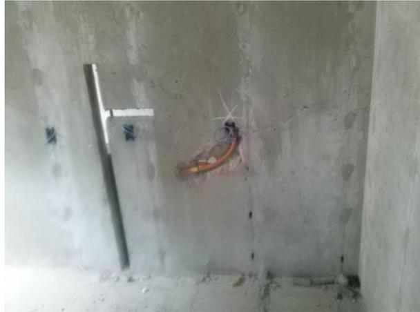
**Figura 24 - Conduite entupido (Fonte do autor)**
