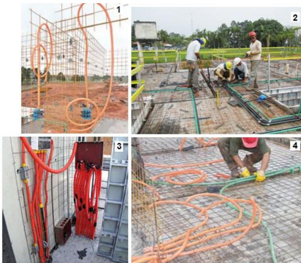
Figura 5 - 1 Caixas presas com grapa, 2 Execução de instalação e fixação dos condutores na laje, 3 Instalação elétrica nas paredes do QDL E 4 Fixação dos conduites na laje (Fonte do autor)
