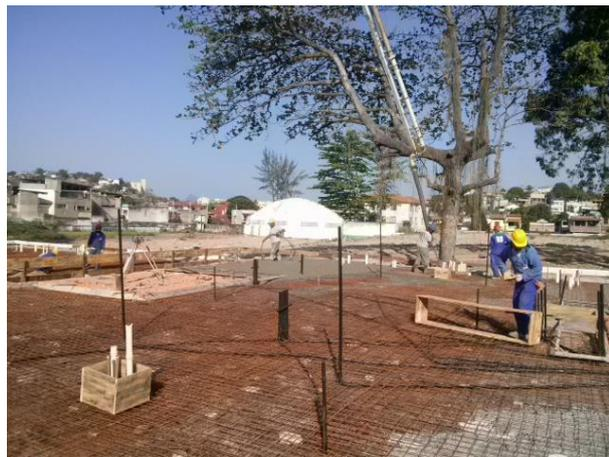
**Figura 25 - Gabarito de madeira para pontos hidráulicos (Fonte do autor)**
