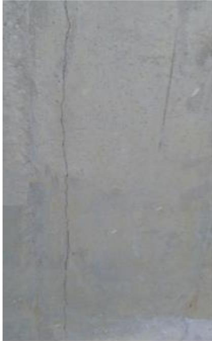
**Figura 19 - Fissura oriunda de instalação elétrica (Fonte do autor)**
