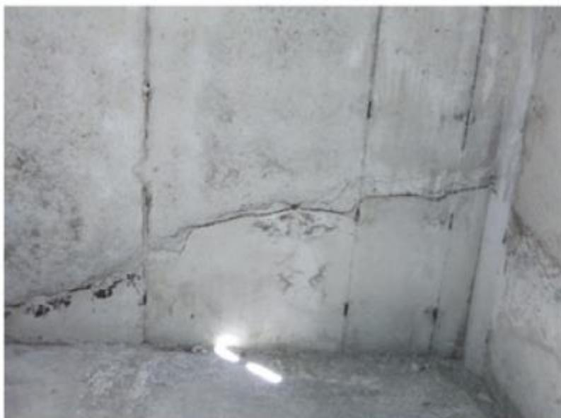
Figura 21 - Junta de descontinuidade do concreto (Fonte do autor)
