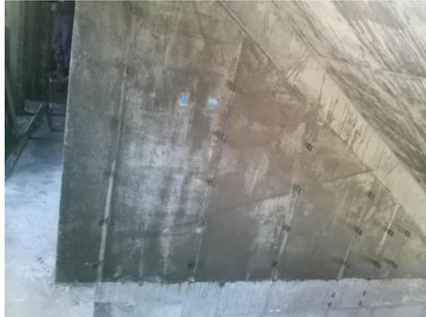
**Figura 18 - Parede com Excesso de Desmoldante (Fonte do autor)**
