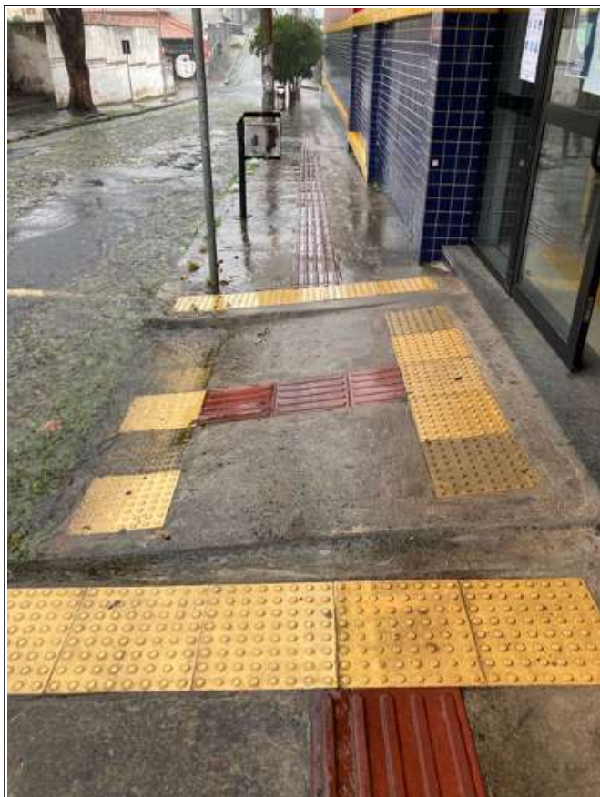
Rampa de acesso da entrada de alunos
