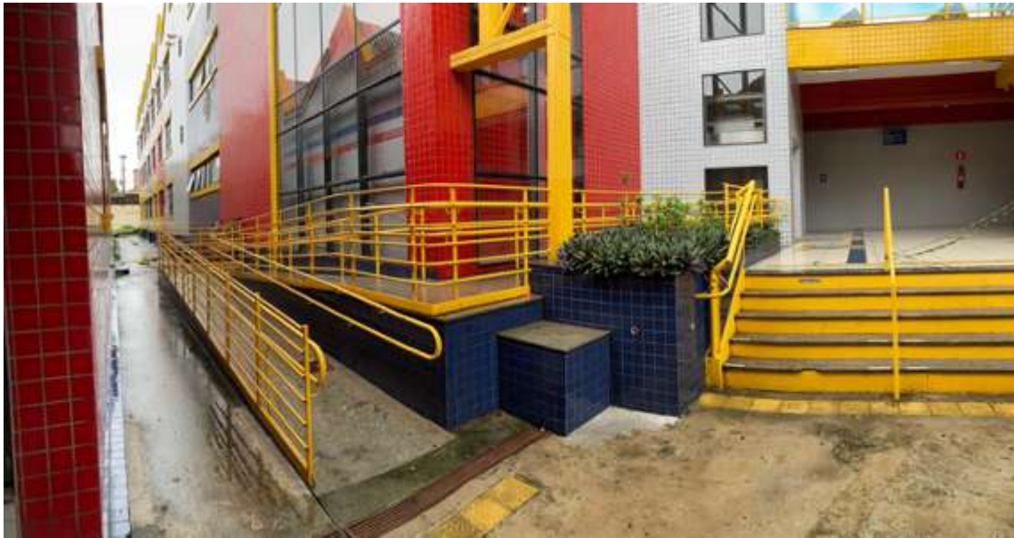
Escada e rampa de acesso ao elevador do Bloco A1
