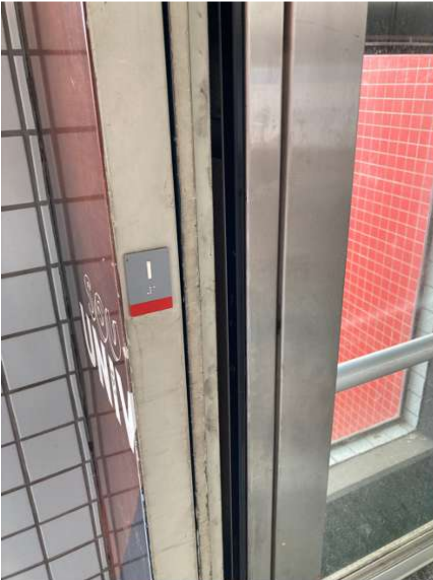
Sinalização do piso do elevador em braile
