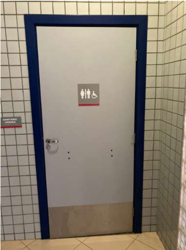
Porta dos sanitários acessíveis
