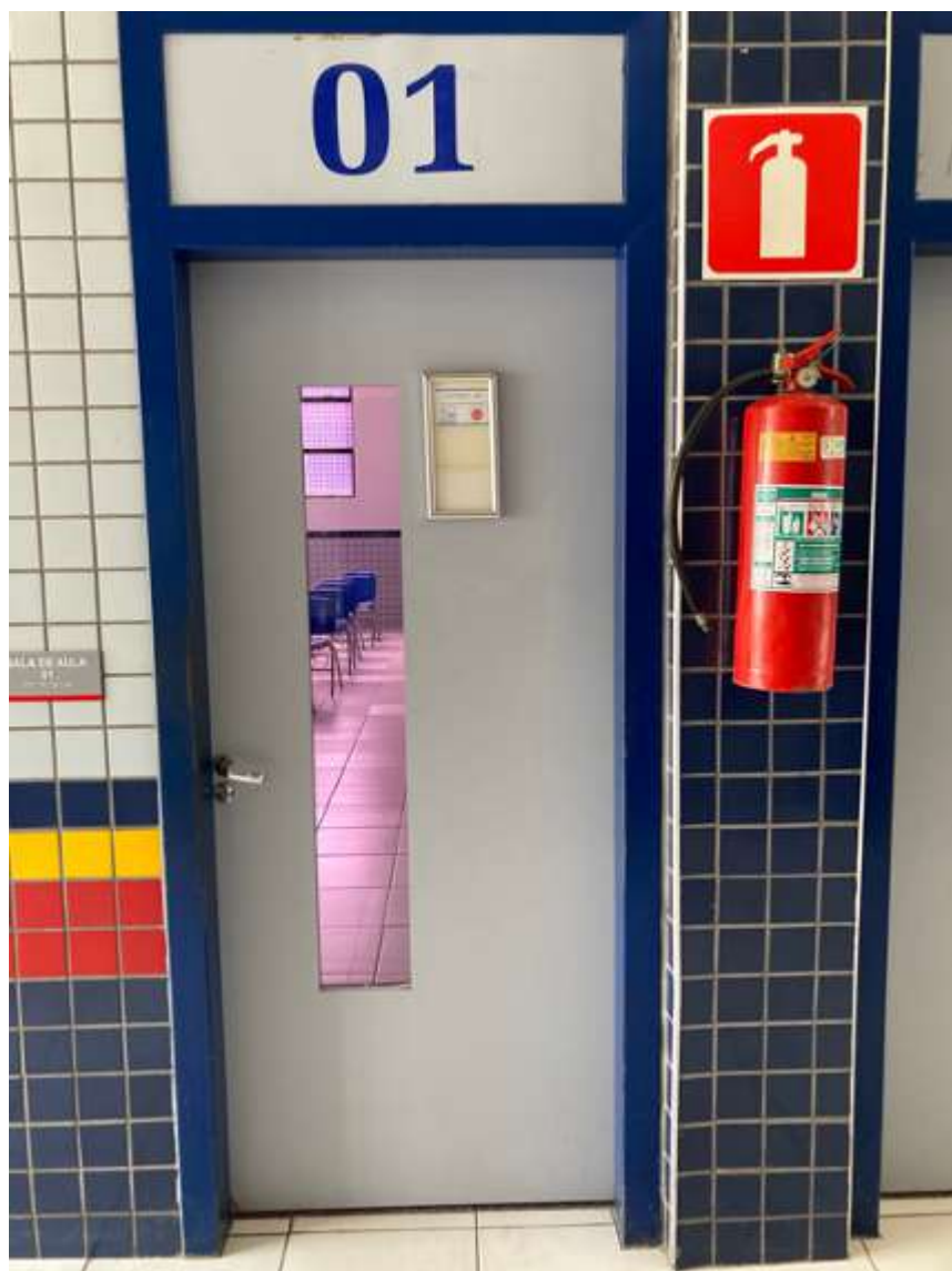
Porta das salas de aula do Bloco B1
